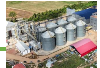
Planta de Transformación de Subproductos de Soya (San Julián) 26-dic-24
