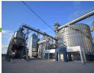
Centro de Almacenamiento y Transformación de Granos (Yacuiba) 13-abr-24
